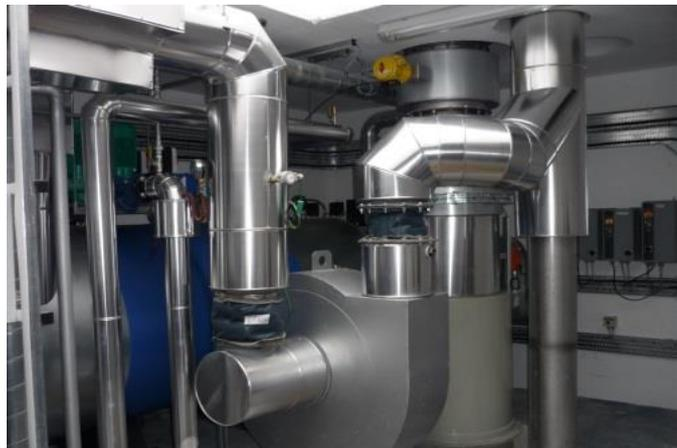
pression. En outre, le ventilateur d'extraction est dimensionné de manière appropriée permettant de surmonter toutes les résistances et les pertes de charge du dispositif de crémation, de refroidissement, du traitement et de filtration des effluents.
