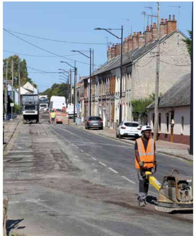
D'importants travaux ont débuté route des Polonais pour une durée estimée à cinq mois. Ce chantier vise le renouvellement et le renforcement des réseaux, avec des interventions sur les branchements d'eau potable et d'assainissement. Une première phase se déroulera avec une route barrée à la circulation, une déviation sera mise en place.
